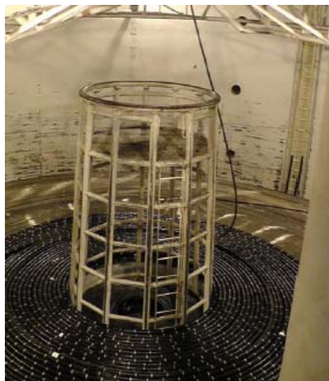
敷設船に積み込まれたケーブル
