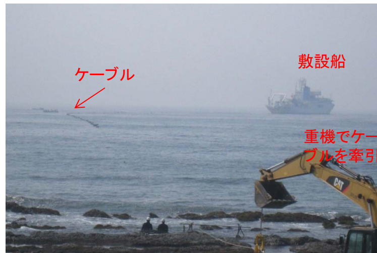
陸揚げ作業風景
