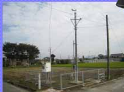
雨量計と基地局への伝送装置
