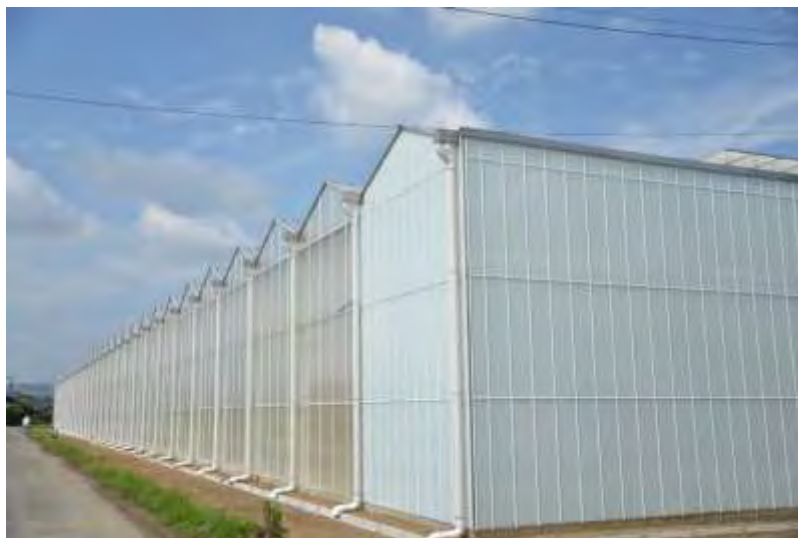
・国内最高軒高6.2m、オランダ/フェンロ型栽培温室
