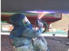
高い疲労強度を持つ鉄鋼溶接手法や固相粉末の超音速吹きつけ手法を用いた、経済的で高信頼な使いやすい補修技術を開発
