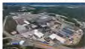
ITERサイトの建設状況
