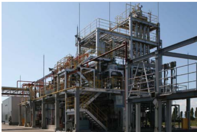
大阪エコタウンに建設された亜臨界水処理プラント (能力70t/日)
