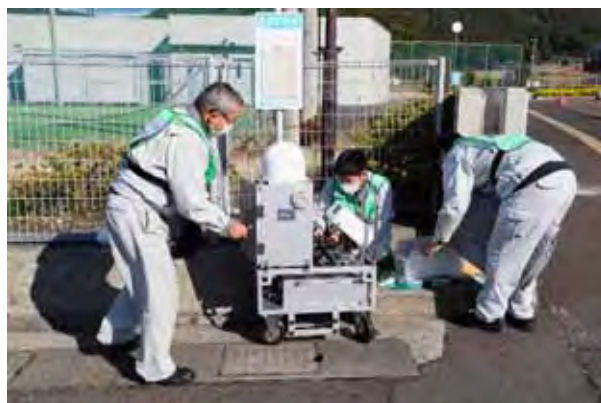
可搬型モニタリングポストの設置
