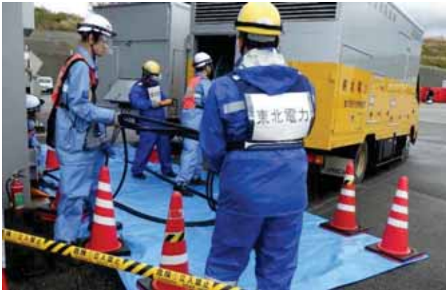
事故収束訓練(東北電力電源車接続による電源復旧)
