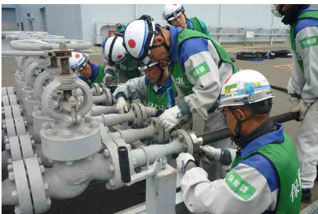
事故収束訓練(ホースの接続)
