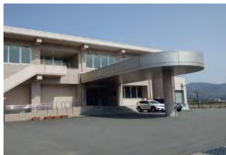
福井県高浜原子力防災センター (高浜町) (無停電電源装置、自家用発電機、 燃料タンク(7日間分)) (発電所からの距離約7km)
