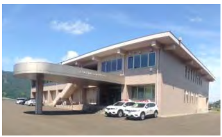
福島県大飯原子力防災センター (おおい町)
