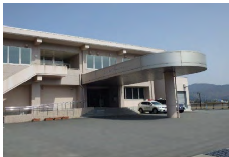
福井県高浜原子力防災センター (高浜町)
