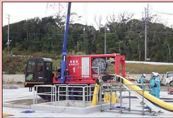
可搬型注水設備操作訓練
