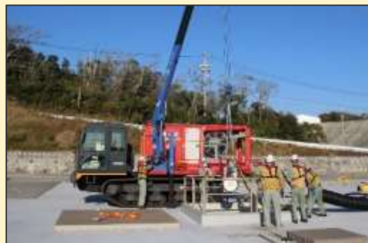
可搬型注水設備操作訓練
