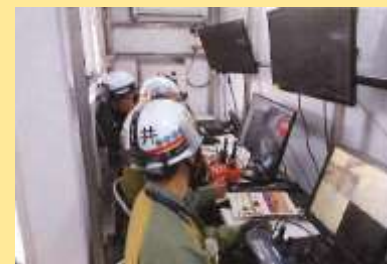
無線重機操作室
