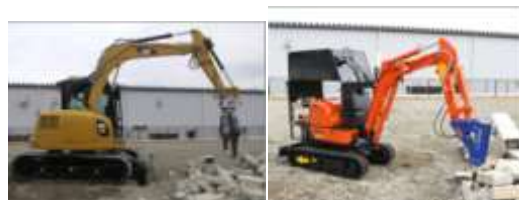
小型・大型無線重機 (屋外の瓦礫等の除去)
