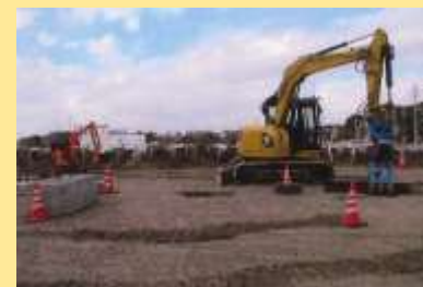
無線重機によるガレキ処理
