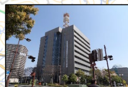
静岡県浜松総合庁舎
