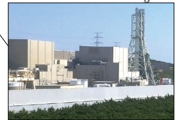
浜岡原子力発電所
