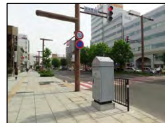
避難経路に46箇所設置
