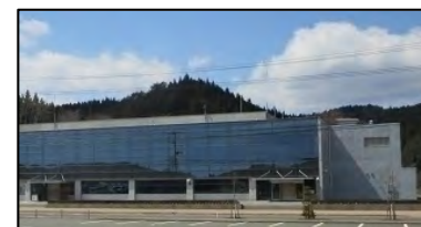
オフサイトセンター (東通村防災センター)
