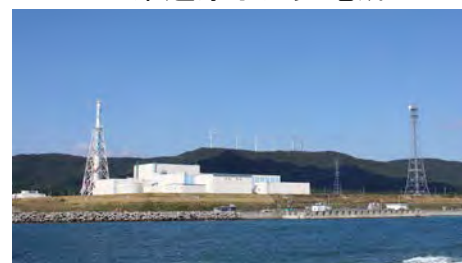
ひがしどおり 東通原子力発電所
