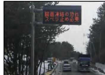
避難経路等に72箇所設置
