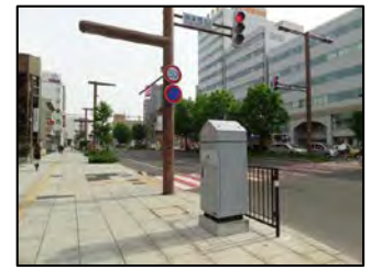
避難経路に46箇所設置
