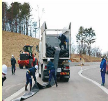
冷却水を移送するためのホース展張訓練
