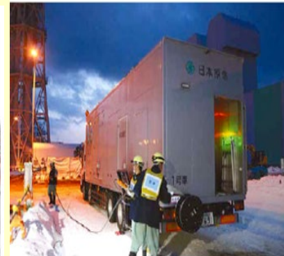
電源喪失時を想定し電源ケーブルを敷設する訓練
