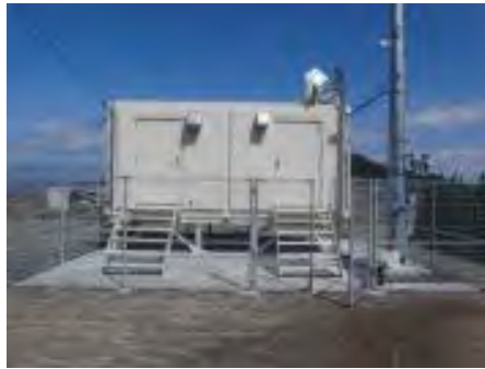
モニタリングステーション【1台】
