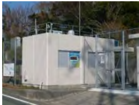
モニタリングステーション等【5台】
