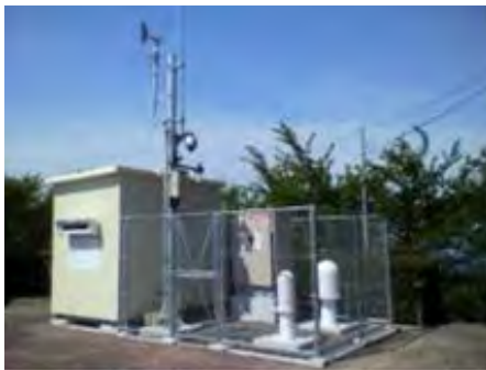
モニタリングステーション【1局】、モニタリングポスト【19局】 (非常用電源装備)
