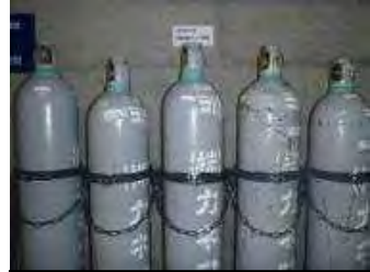
予備ポンベの配備
