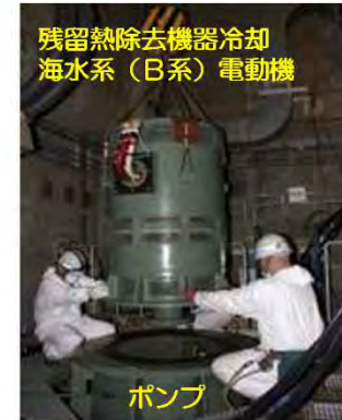
残留熱除去機器 冷却海水系 (B系) 電動機の据付作業
