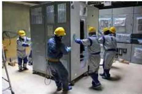
1号機 電源盤 (P/C 1C-1) 据付作業
