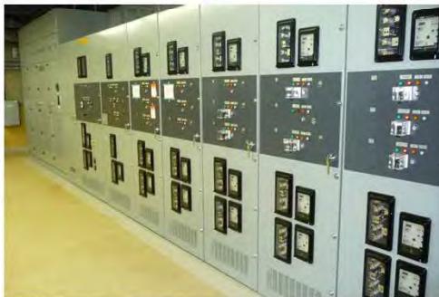
1号機 電源盤 (P/C 1C-1) 据付後
