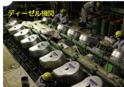
1号機 非常用ディーゼル発電機(A) 復旧作業
