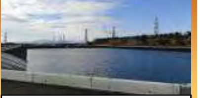
淡水貯水池設置
