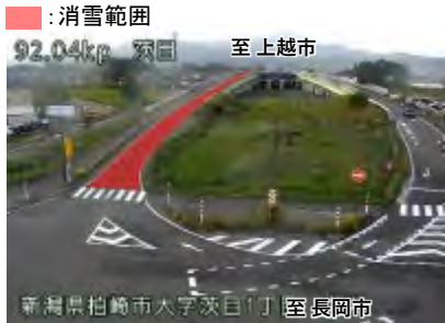
【対応⑤: 除雪効率化】 R8柏崎高架橋(下)に消雪パイプ設置
