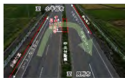
【対応⑦: 早期通行止め解除に向けた対策】 中央分離帯開口部を設置(R17青木町)
