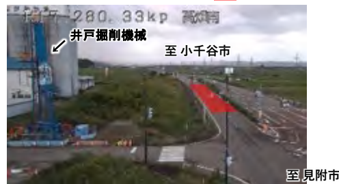
【対応③: 立ち往生発生を予防】 R17高畑南交差点前後の上り勾配車線に消雪パイプを設置
