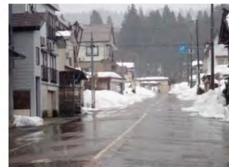
消融雪対策(消雪パイプ)
