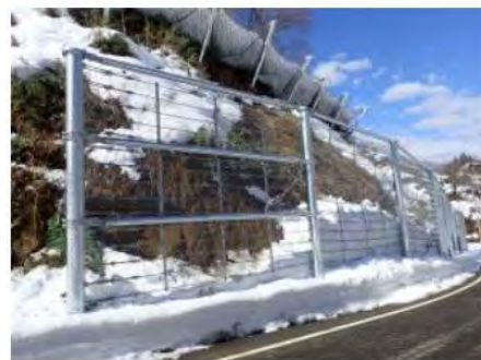
法面对策(防雪施設)
