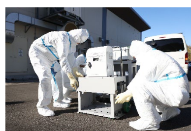
可搬型モニタリングポストの設置
