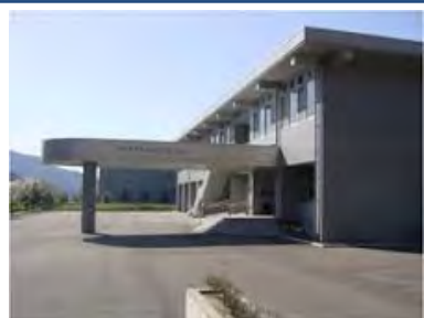
オフサイトセンター (福井県大飯原子力防災センター) (発電所からの距離約 8km)
