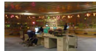
シミュレータ訓練 (非常灯照明下)
