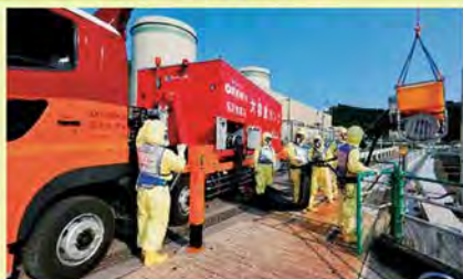
取水用水中ポンプ設置の様子
