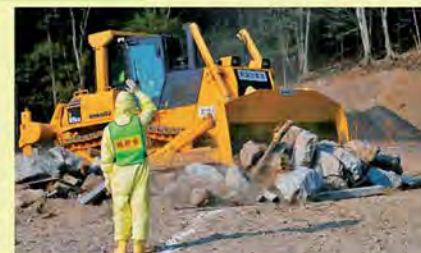
がれき撤去訓練の様子
