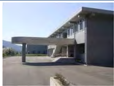
オフサイトセンター (福井県大飯原子力防災センター) (発電所からの距離約 7km)
