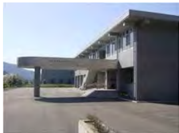
大飯オフサイトセンター (発電所からの距離約 7km)
