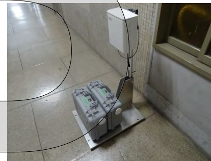
可搬型モニタリングポスト【12台】
