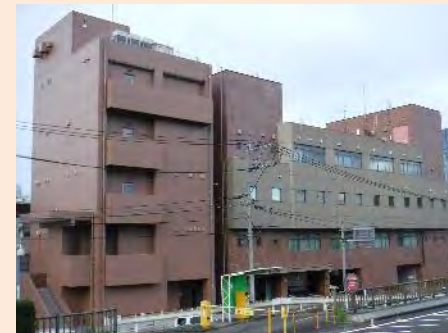
鹿児島県原子力防災センター 〔放射線防護対策設備、無停電電源装置、非常用発電機を設置〕 (発電所からの距離約11km)
