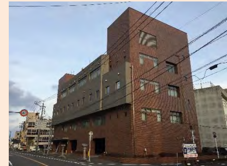
川内オフサイトセンター (鹿児島県原子力防災センター) 〔放射線防護対策、無停電電源装置、非常用発電機 (3日間運転分の燃料を備蓄)を設置 (発電所からの距離約11km)〕
