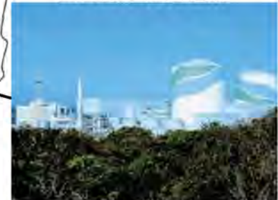
川内原子力発電所
