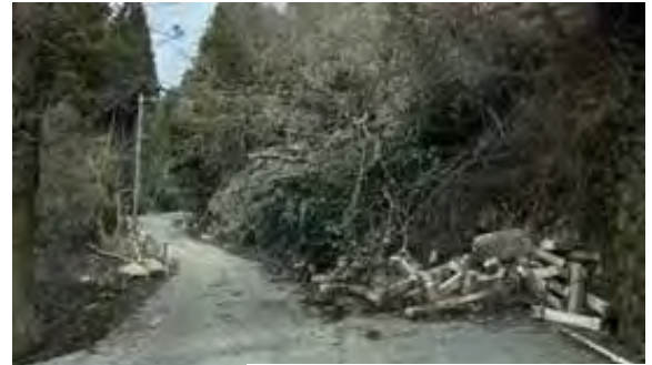
道路の被害状況(啓開済)
