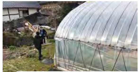
集落内の倒壊住居と退避時に使用されたビニールハウス
