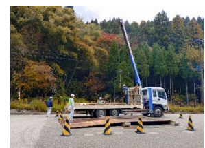
重機による段差解消訓練
