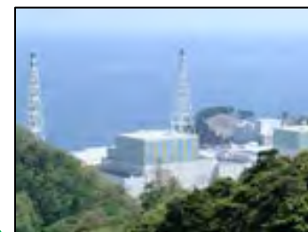
島根原子力発電所
