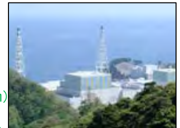
島根原子力発電所
