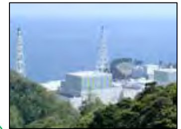
島根原子力発電所
