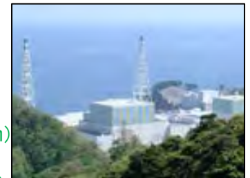
島根原子力発電所
