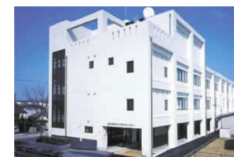
島根県原子力防災センター (オフサイトセンター)
