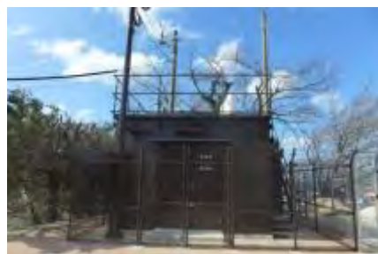
モニタリングステーション・モニタリングポスト (非常用発電機装備)
