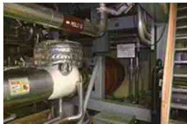
耐震補強工事前
