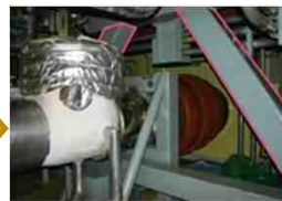
耐震補強工事後
