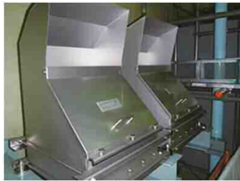
静的触媒式水素処理装置
