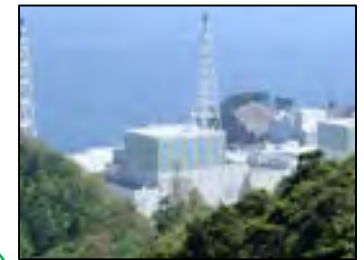
島根原子力発電所
