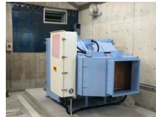
オフサイトセンターに設置された非常時外気取り入れユニット
