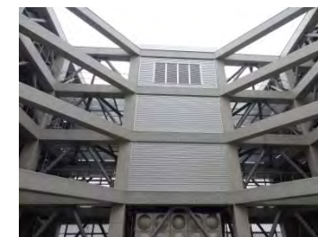
島根県庁に増築された非常時外気取り入れユニットの格納建屋
