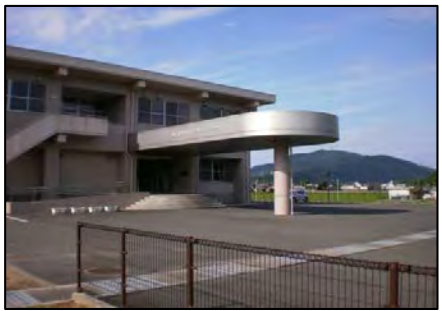
福井県高浜オフサイトセンター (高浜町) 〔無停電電源装置、自家用発電機 燃料タンクの増設(7日分)〕 (発電所からの距離約7km)
