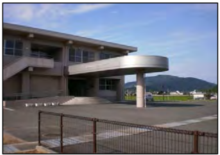
福井県高浜オフサイトセンター (高浜町) 〔 無停電電源装置、自家用発電機 〕 燃料タンクの増設(7日分) (発電所からの距離約7km)
